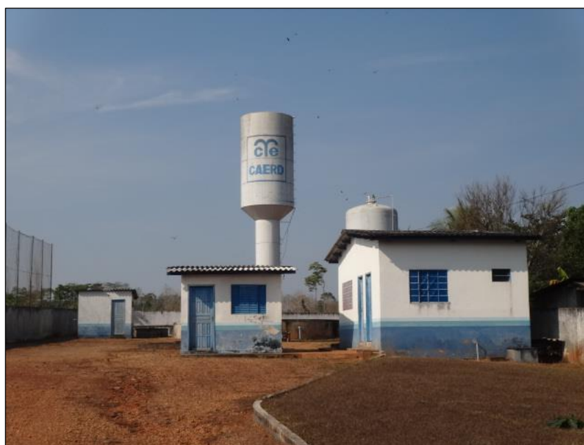
Figura 101 - Área da Estação de Tratamento do Distrito Nova Esperança Fonte: ECP Soluções, 2017.
