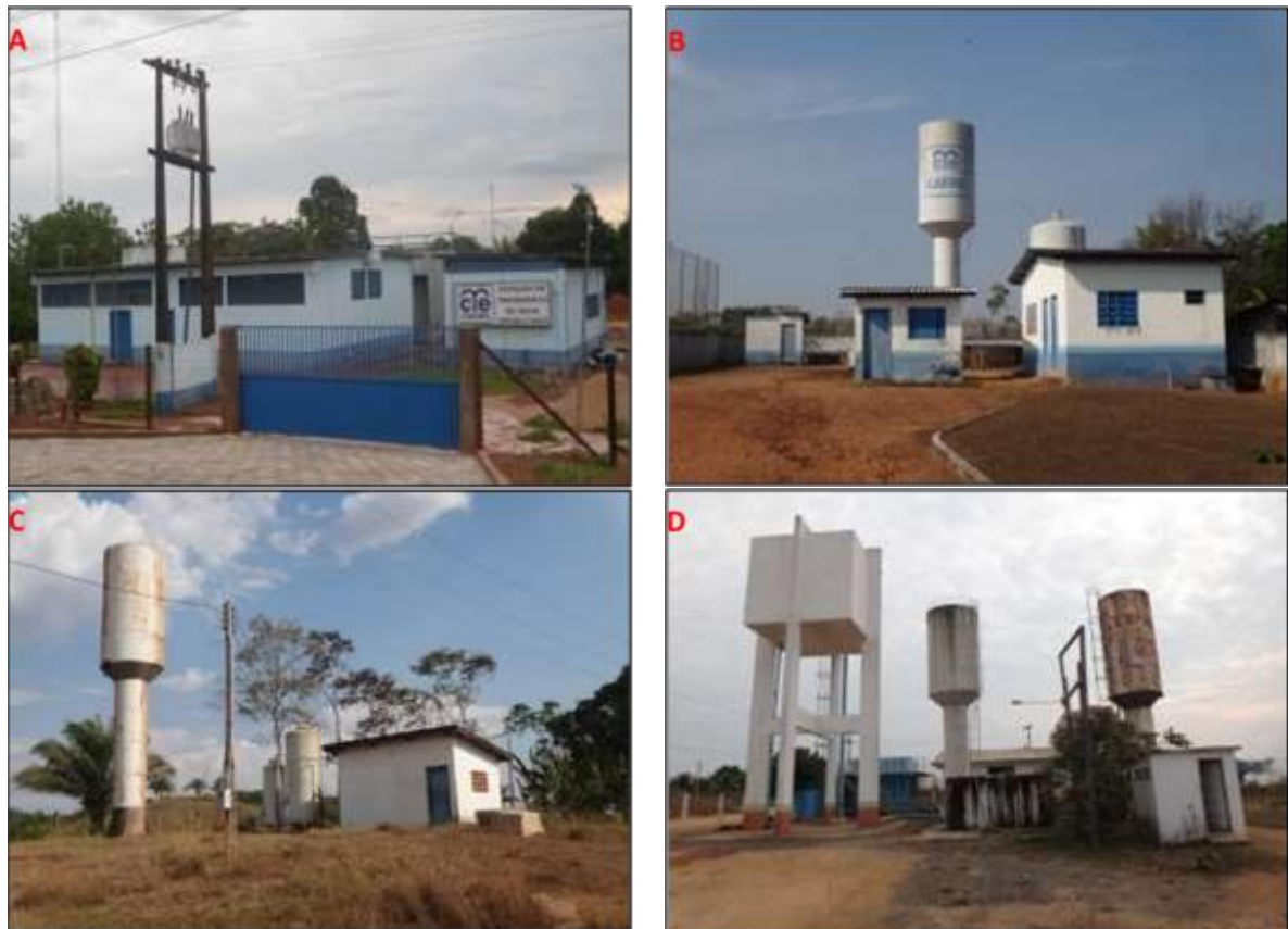
Figura 13 - Sistemas de Abastecimento de Água existentes no Município de Espigão do Oeste
