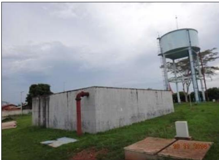
Figura 41 - Sistema de reservação de água tratada na Sede Municipal Fonte: E.C.P. Soluções (2014).
