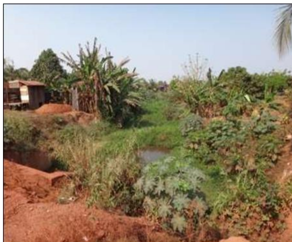
Figura 70 - Canal de macrodrenagem natural Fonte: E.C.P. Soluções (2014).
