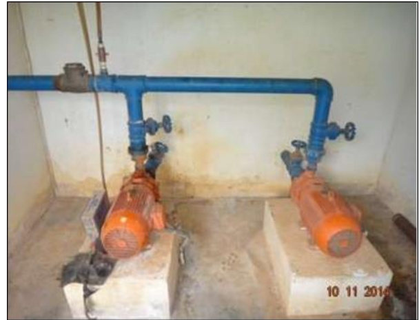
Figura 24 - Conjunto motor-bomba Fonte: E.C.P. Soluções (2014).
