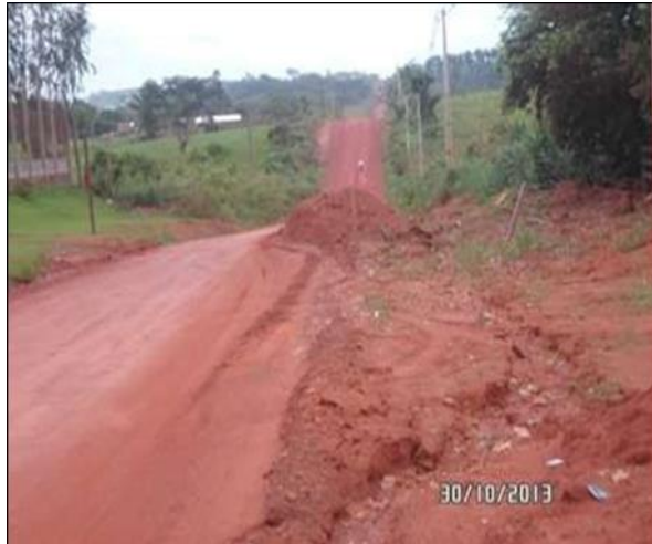
Figura 79 - Ocorrência de erosão na margem da via pública de Espigão do Oeste Fonte: E.C.P. Soluções (2014).
