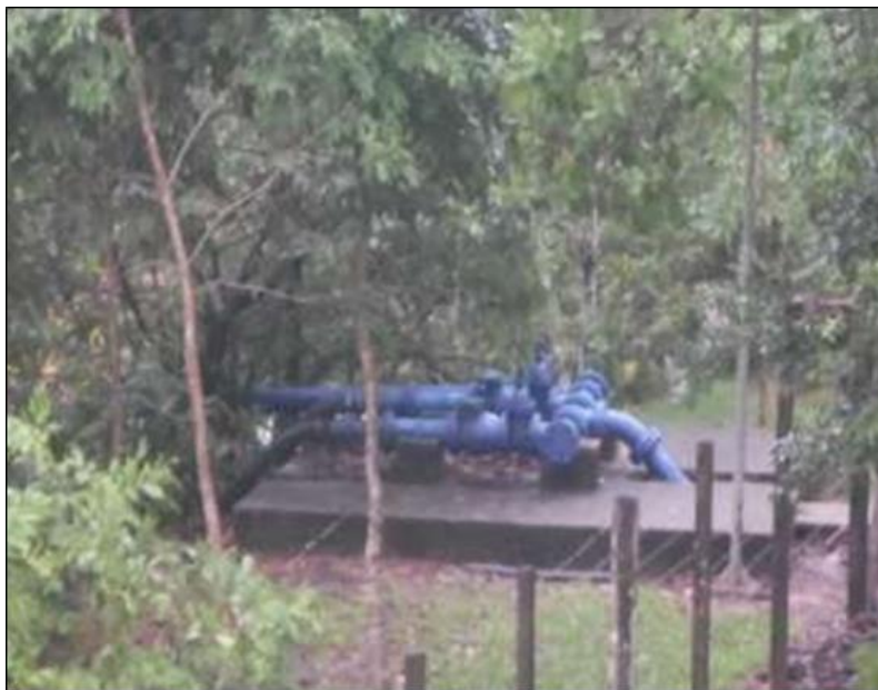
Figura 22 - Sistema pressão para adução da água bruta Fonte: E.C.P. Soluções (2014).
