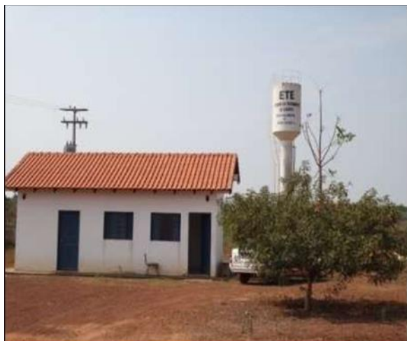
Figura 58 - Estação de Tratamento de Esgoto
