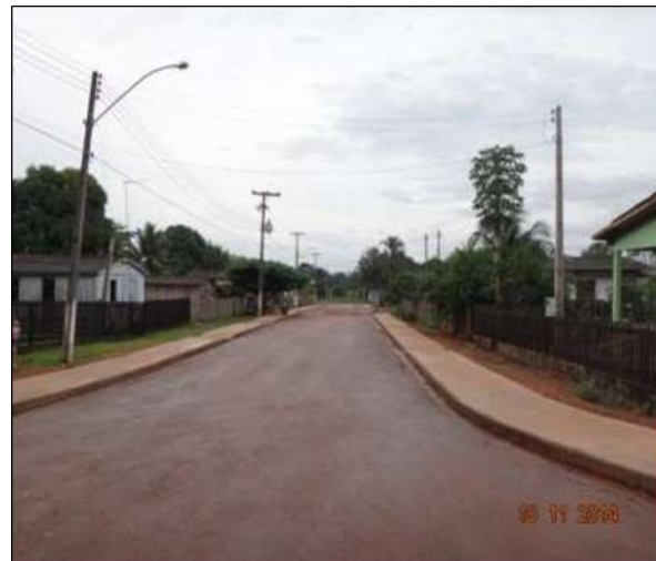
Figura 76 - Rua pavimentada com presença de calçadas e sarjetas para escoamento da água Fonte: E.C.P. Soluções (2014).
