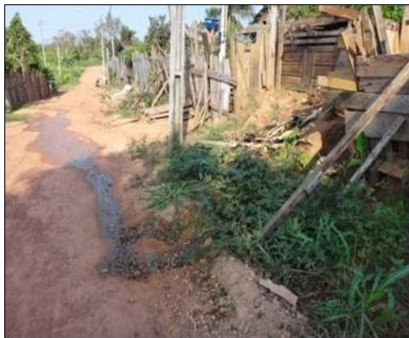
Figura 51 - Lançamento de água servida a céu aberto
