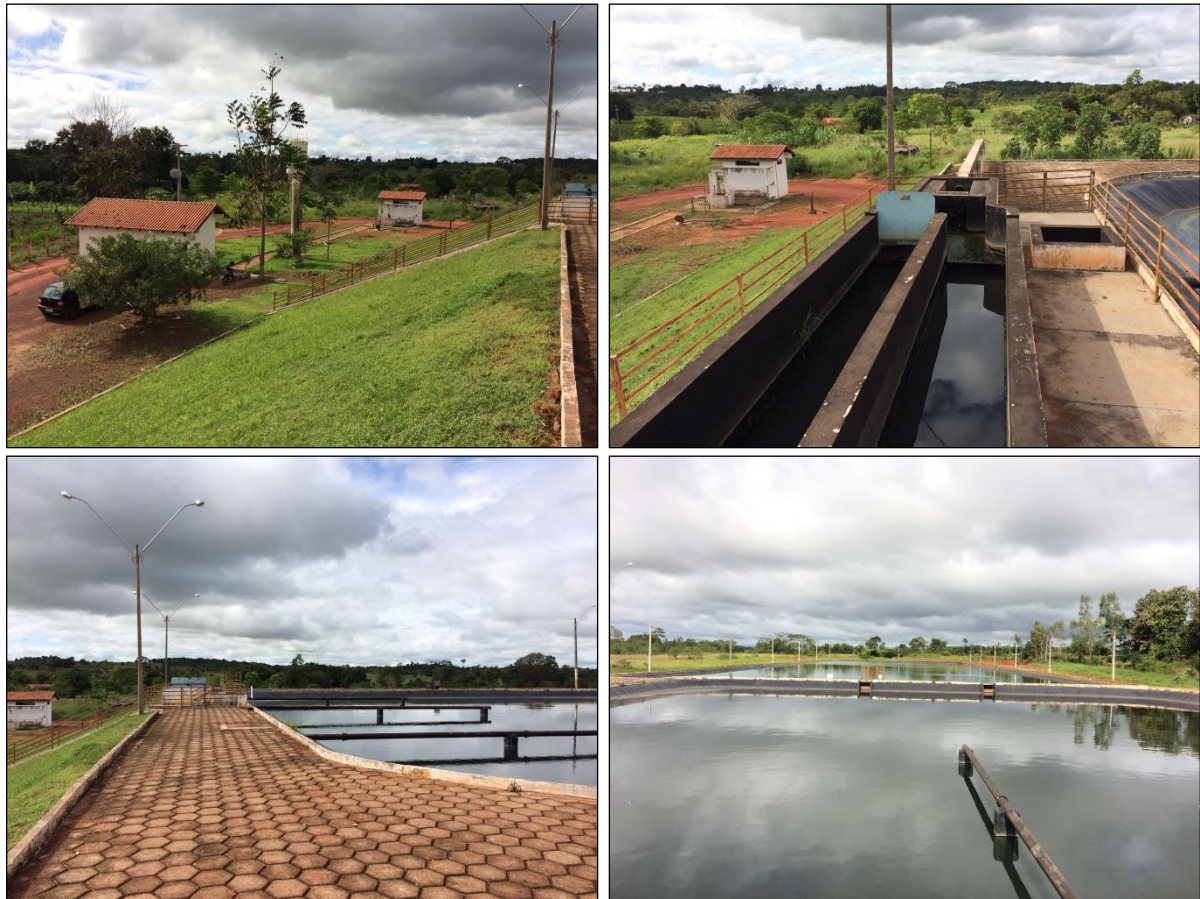
Figura 107 - Estação de Tratamento de Esgoto do município de Espigão do Oeste Fonte: ECP Soluções, 2017.
