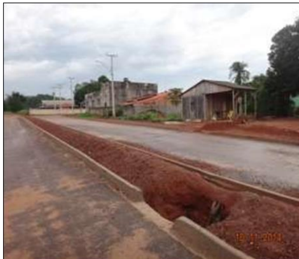
Figura 75 - Meio-fio com presença de boca de lobo pra receber as águas pluviais Fonte: E.C.P. Soluções (2014).
