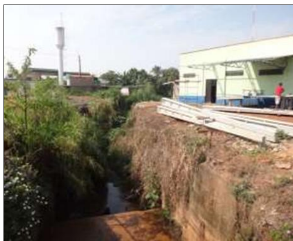
Figura 68 - Canalização de córrego Fonte: E.C.P. Soluções (2014).
