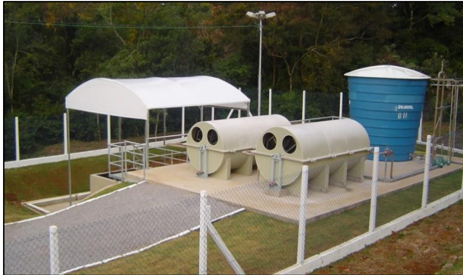
Figura 110- Imagem ilustrativa de um sistema Biodisco Fonte: Verlag, 2016.
