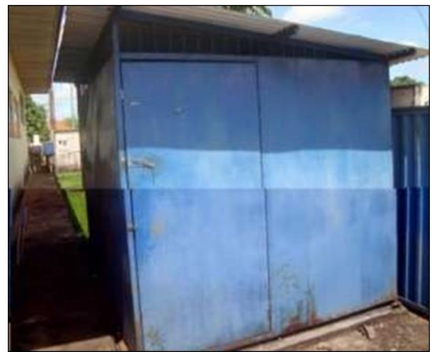
Figura 91 - Vista frontal do local de armazenamento temporário do RSS
