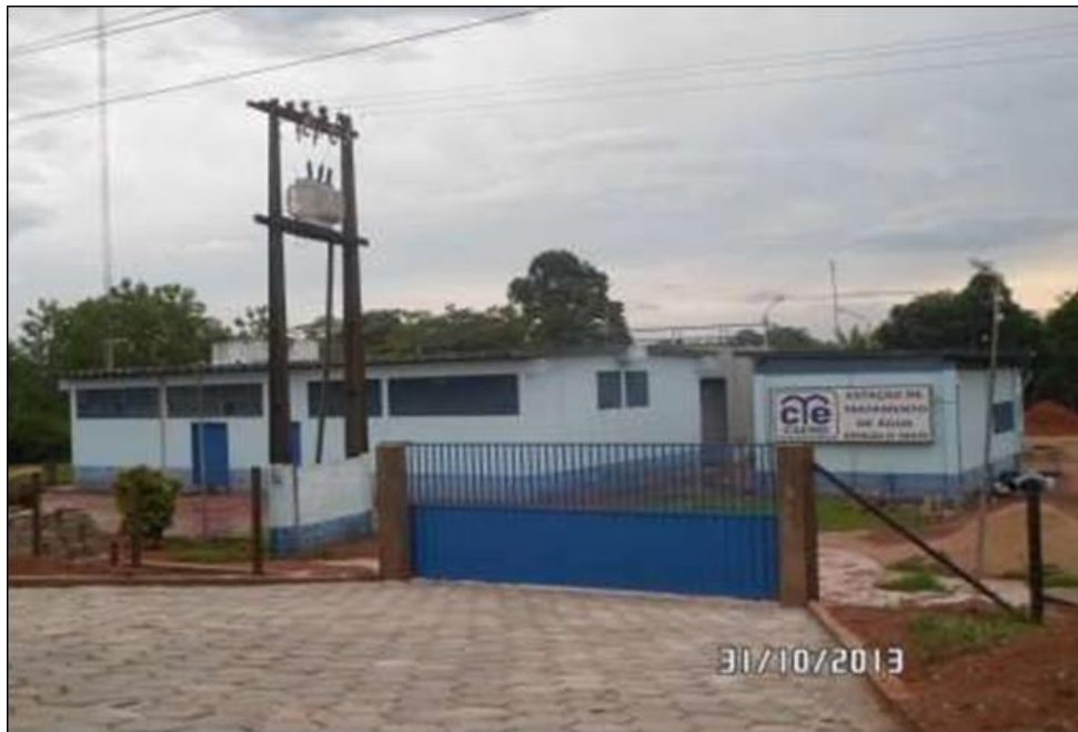
Figura 26 - ETA na Sede Municipal de Espigão do Oeste
